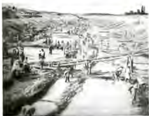
Катта Чуй каналининг қурилиши 1941 йил.
